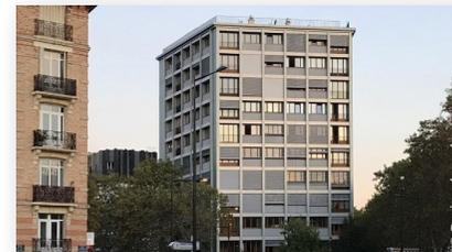
En 2014, l'immeuble est énergivore et son architecture des années 60 renvoie une image peu valorisante. Une nouvelle « peau extérieure » du bâtiment a été mise en place : elle intègre l'isolation thermique, la protection solaire et l'occlusion. Les persiennes existantes ont été remplacées par des stores à lames brise-soleil orientables totalement intégrés dans la nouvelle façade. Cette nouvelle peau rend à l'immeuble son lustre et son homogénéité
